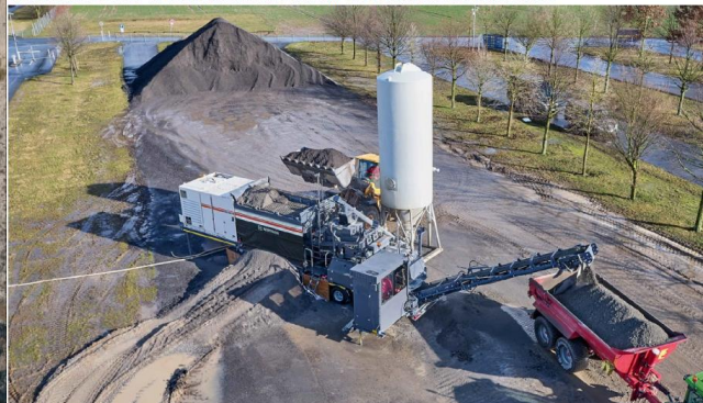
ESEMPIO DI UTILIZZO DI WIRTGEN KMA200 PER L'IMPIEGO DI AGGREGATO RICICLATO
